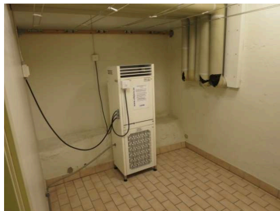
Torkrum med avfuktare (ca 5-10 års kvarvarande livslängd)
